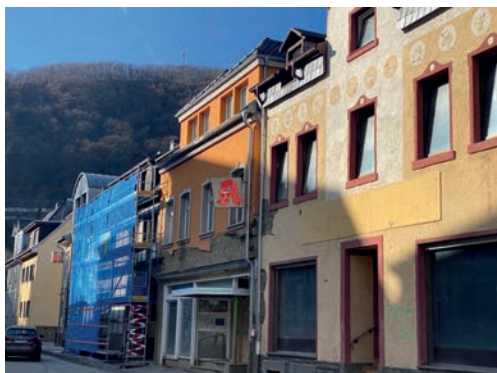
Bestandsgebäude in Altenahr im Januar 2022
