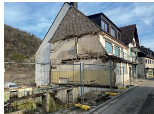
Verlorene Bausubstanz in Altenahr im Januar 2022
