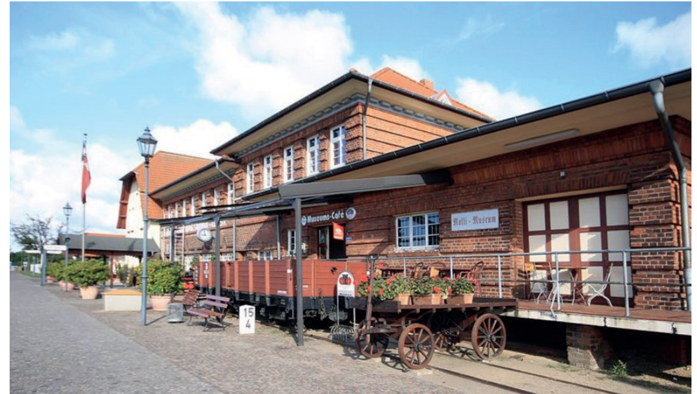
Bahnhof Kühlungsborn West Quelle: ©Mecklenburgische Bäderbahn
