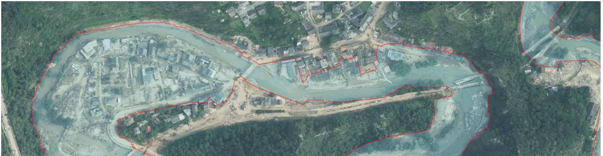
Luftbild 2021 nach der Flutkatastrophe mit vorläufig sichergestelltem Überschwemmungsgebiet Quelle: ©GeoBasis-DE / LVermGeoRP 2021
