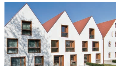
Ingolstadt (D) Quelle: ©nbundm Architekten
